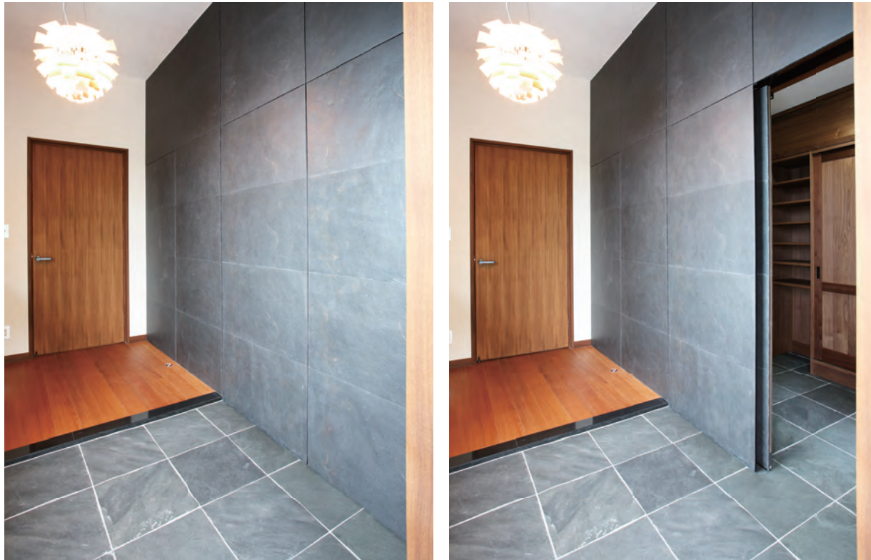
玄関に設けたシューズクローズへの入口のドア。壁の仕上げもドアと同じく製作、仕上げをHALSTONE(天然石)にする事でドアを閉じてしまうと完全に隠し扉となっている。開閉は軽く押すだけでレールに添って開いてくれ、閉まる時もソフトクローズで軽い使用感に驚く。
