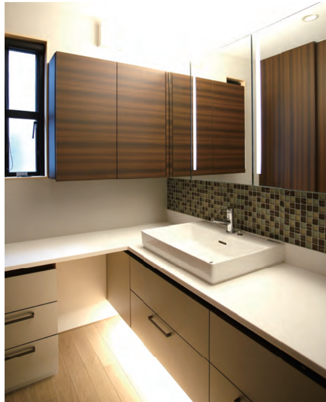
洗面家具の扉はメラミン化粧仕上げ。鏡部分も収納になっています。 鏡に施されたスリット照明で、よりおしゃれな雰囲気。
